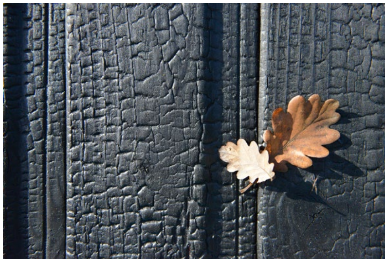
Bardage yakisugi huilé qui sèche avant la pose
